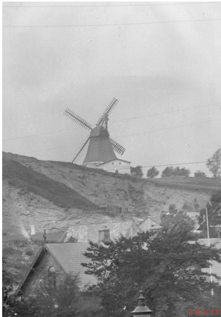
Foto: Bemærk gadebelysning, el - og telefonledninger
