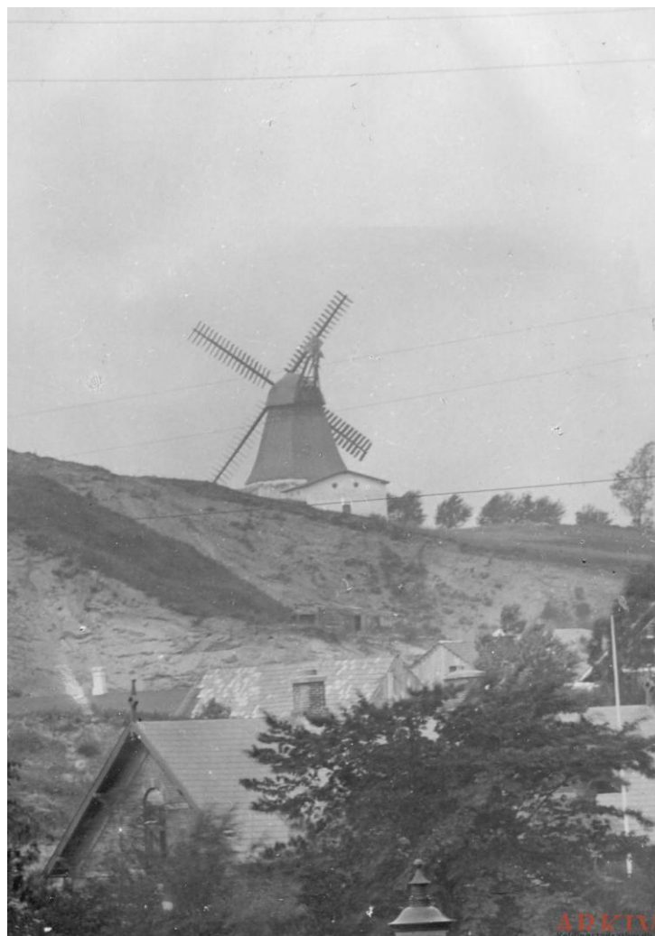
Foto: Bemærk gadebelysning, el - og telefonledninger
